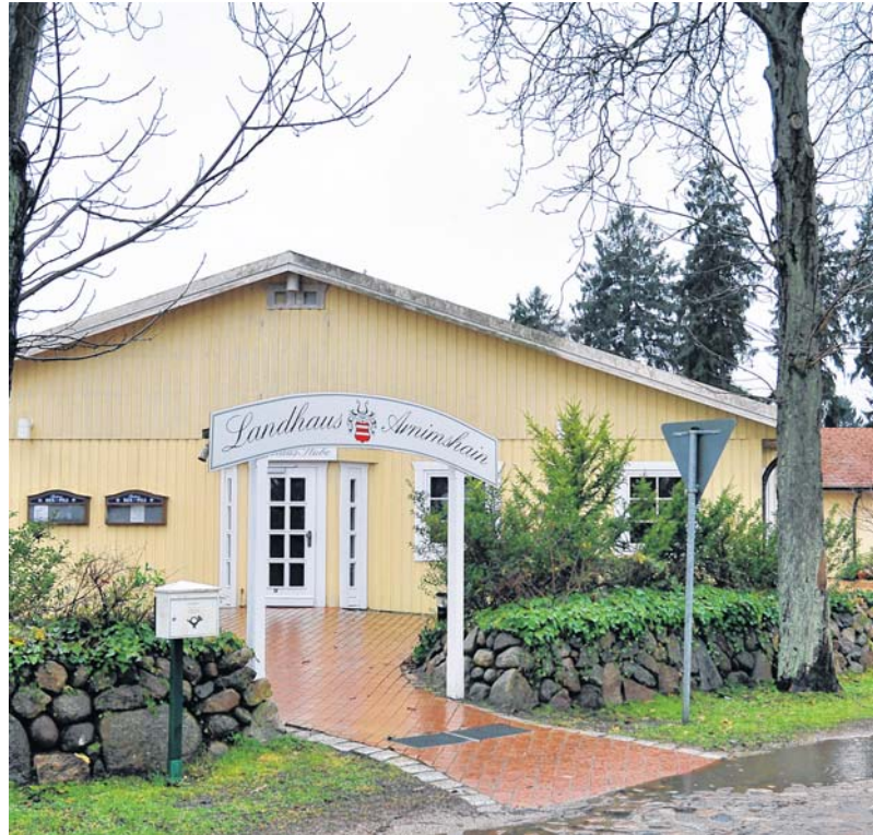
Im „Landhaus Arnimshain“ in Buchenhain wird derzeit kräftig investiert. Schon bald soll hier Erdwärme zum Heizen genutzt werden. FOTO: UWE WERNER
